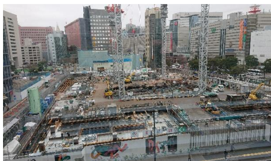
建設中の(元)福岡ビル(5階の弊社より撮影)
